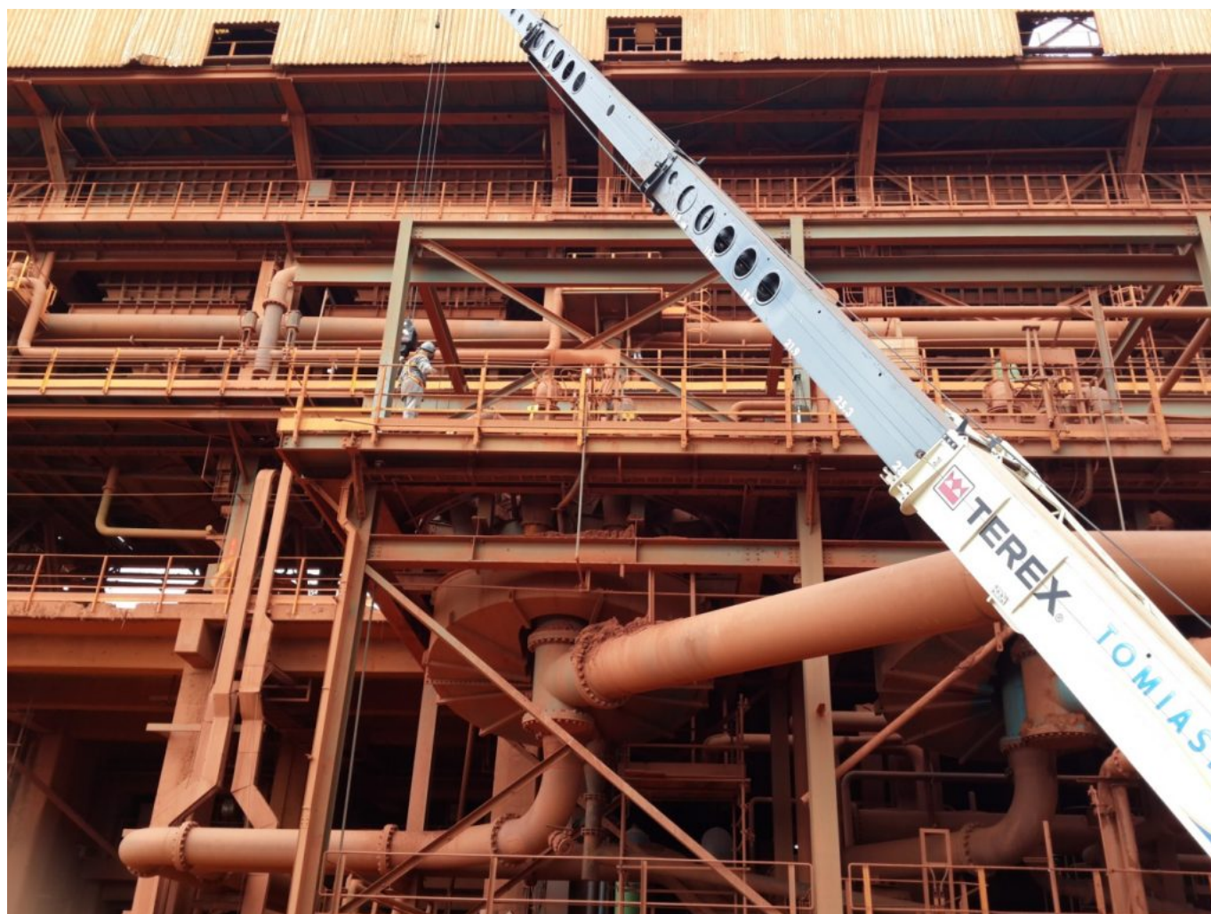
Figura 4. Vista parcial da planta de beneficiamento de bauxita.
