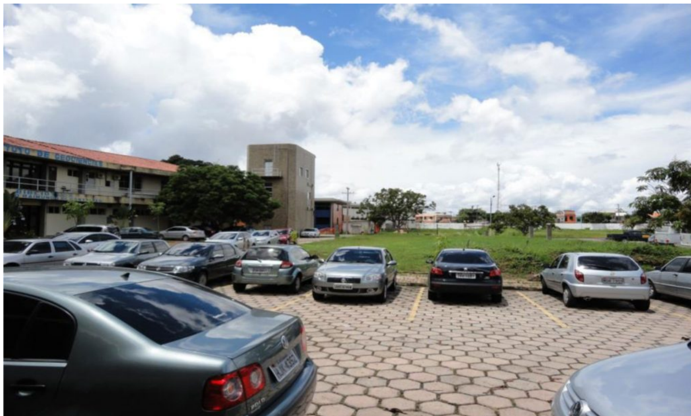
Figura 2. Vista lateral da área disponível para construção do Museu de Geociências da Amazônia, destacando-se as estacas de fundação expostas.
