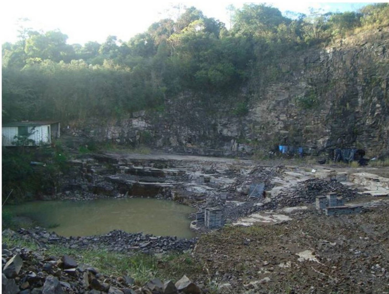
Figura 2 – Aspecto geral da Pedreira Analu, Município de Nova Prata, RS – 324.
