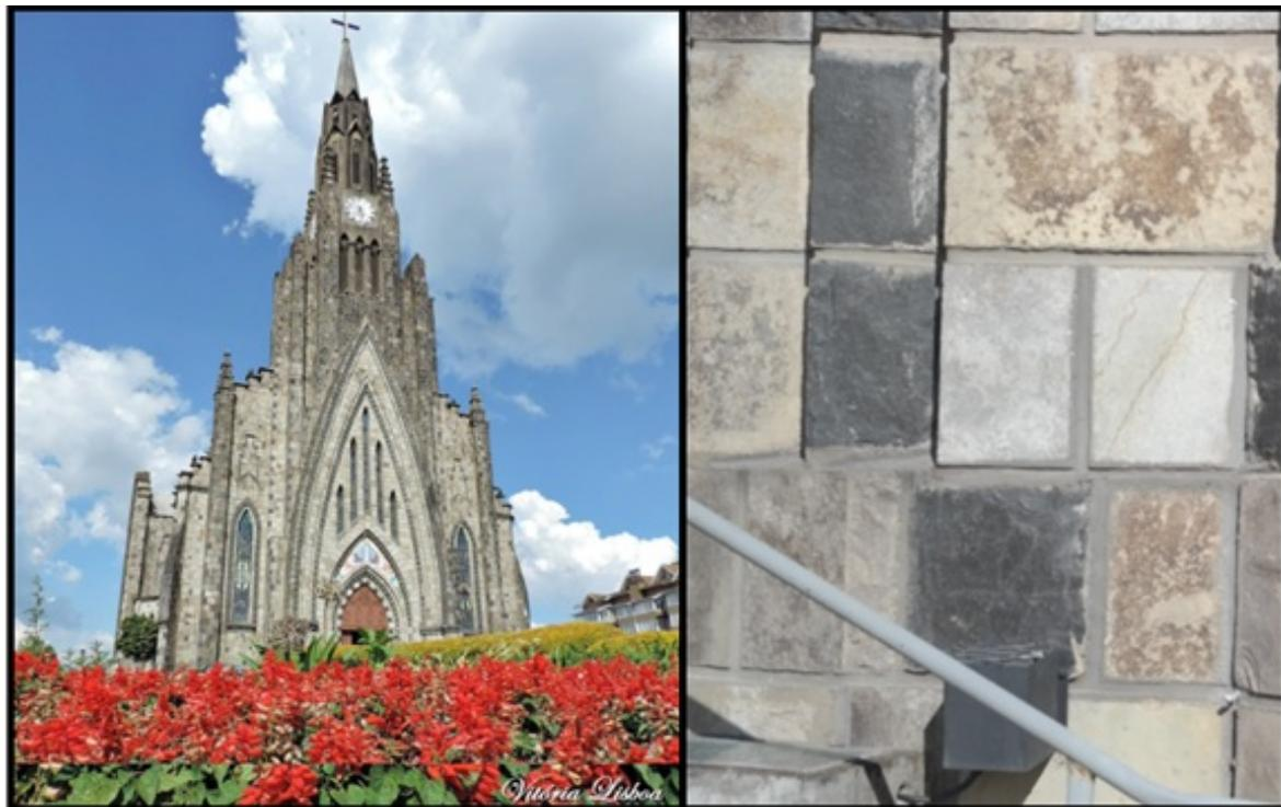
Figura 8 – Igreja NS de Lourdes, em Canela, com detalhe dos blocos de rocha(basalto) de dimensões 20x30cm, 25x30cm e 50x30cm, usados na construção. Fonte: <http://paroquiadecanela.com.br/>
