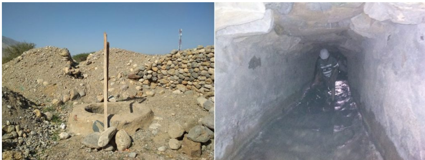
Figura 14 Poço de acesso (ou de controle) de túnel, e túnel de um Dawudi Aflaj.
