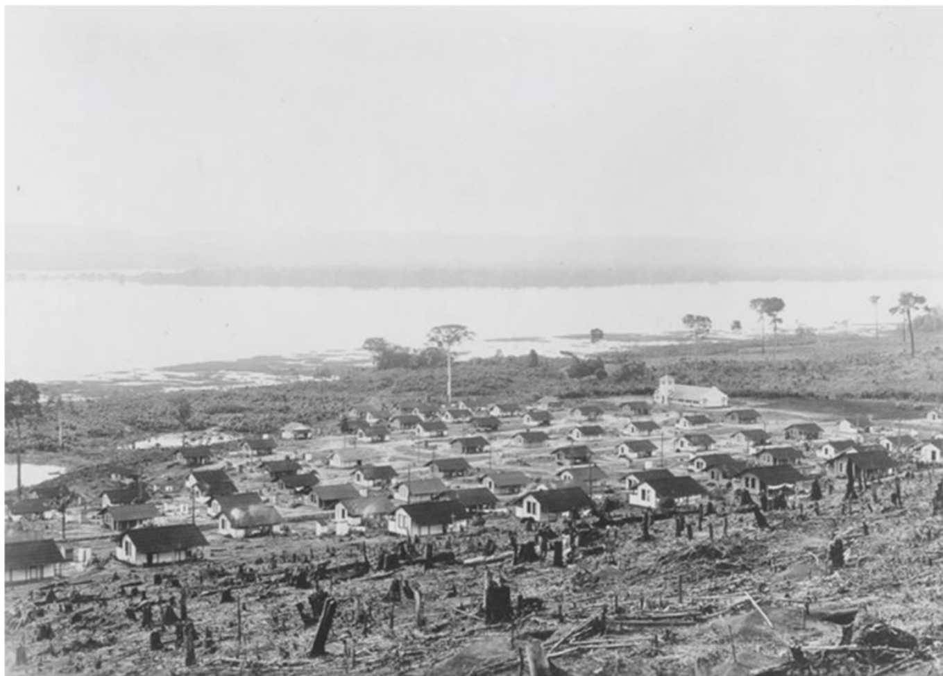
Figura 13 –Vila Operária de Fordlândia em fase final de construção em 1930 (Sena, 2008).
