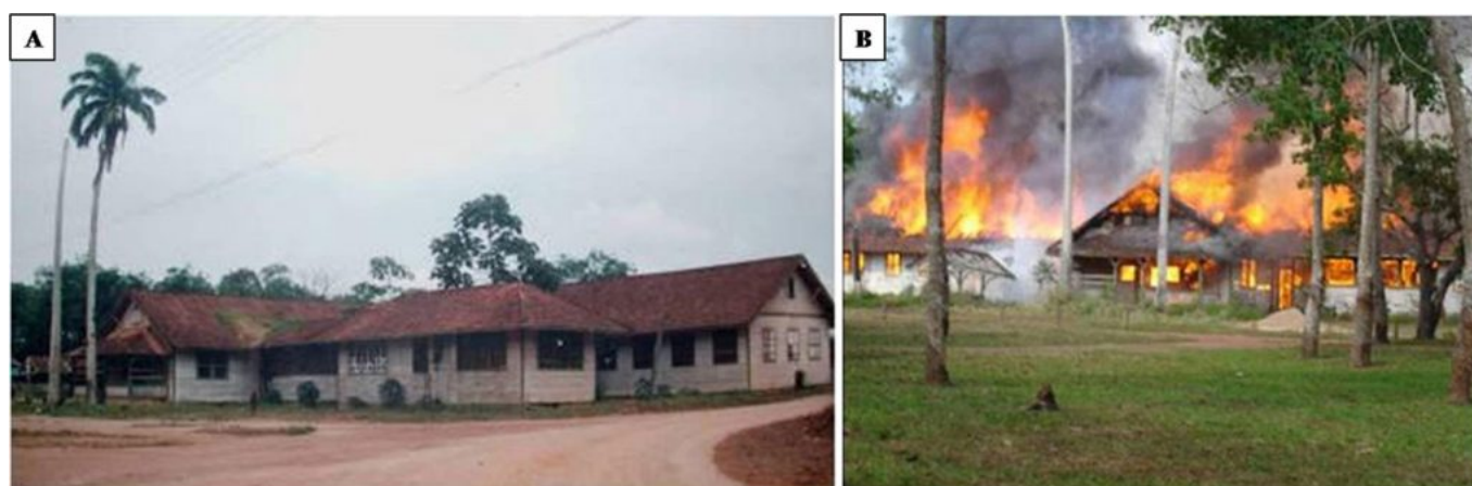
Figura 15 – Hospital de Belterra. A) Prédio desativado em 1992. B) Consumido pelo fogo em 2005. Disponível em: http://belterradotapajos.blogspot.com/2010/11/hospital-henry-ford.html . Acessado em 10 mar. 2019.
