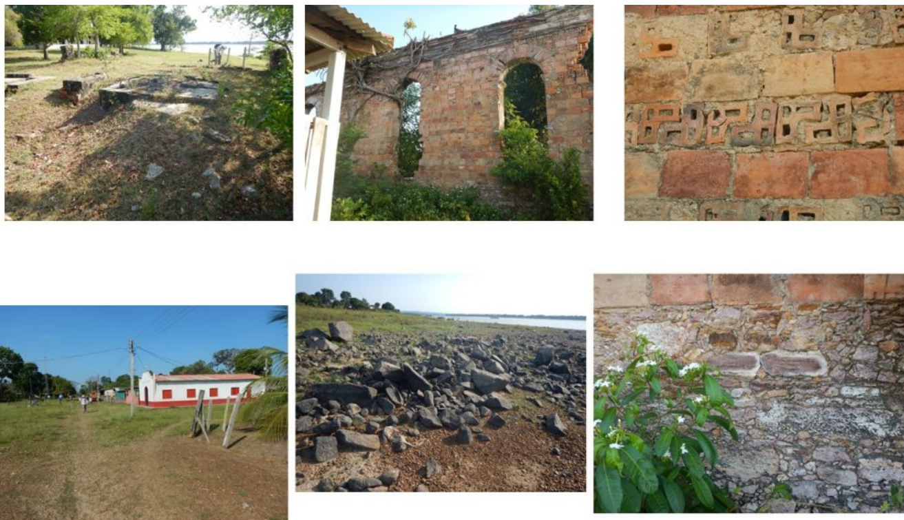
Figura 81 - Acima à esquerda a base de possível engenho de moer cana; a sua direita nas três imagens seguintes paredes e detalhe das mesmas da capela em tijolo em L e pedra; e no centro abaixo o afloramento de diabásio em frente o casarão; e a rua que leva ao casarão e passa pela capela nova.
