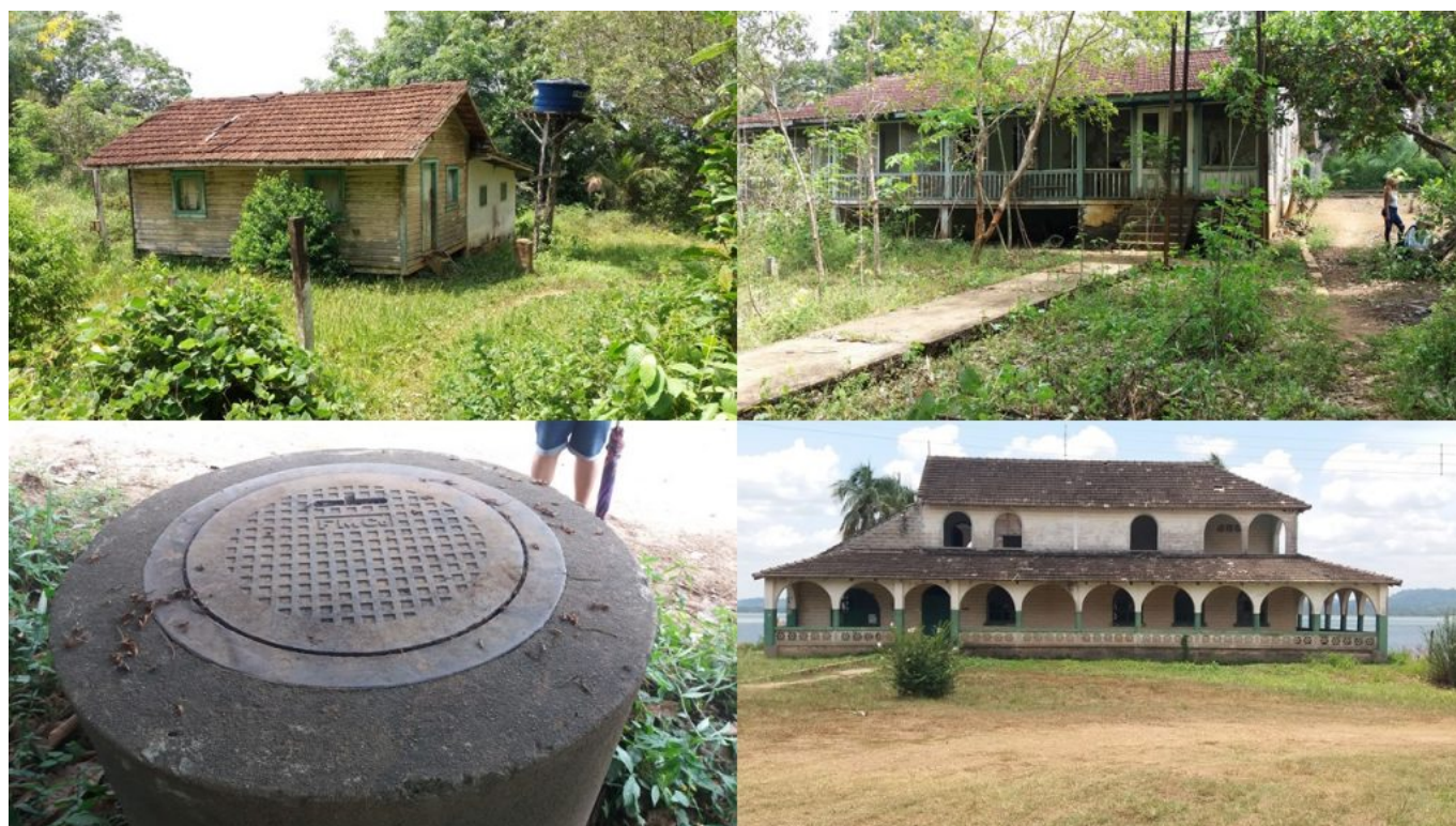
Figura 68 - Outro modelo de casa operária com puxadinha; à direita outro modelo de casa, ampla; abaixo o casarão do gerente; e finalmente sobrevivente magnífico do sistema de drenagem subterrâneo.
