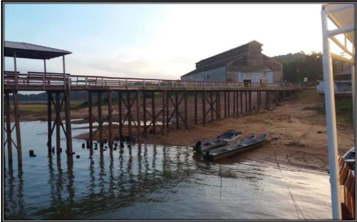
Figura 54 - Vista do cais/trapiche em madeira e ao fundo o belo galpão, se sentindo abandonado, subutilizado, mas ainda resistindo com sua imponência. São 6:11 h.
