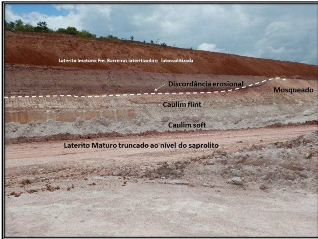
Figura 3 – A frente de lavra de caulim na mina PPSA destacando os principais materiais geológicos, com ênfase ao caulim na base.
