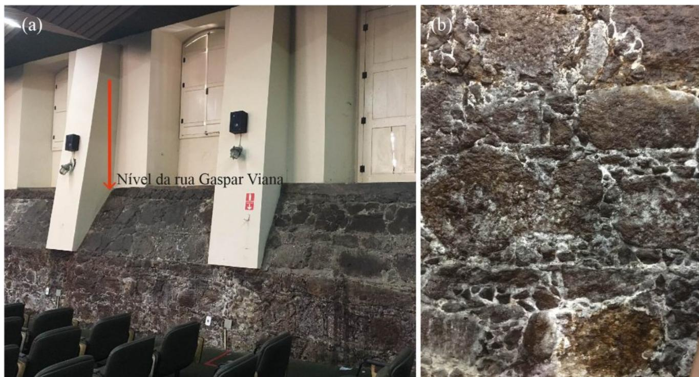
Figura 4. (a) Vista das fundações aparentes em alvenaria de pedra argamassada no auditório do Convento dos Mercedários; (b) Detalhe das rochas (arenitos ferruginizados) e eflorescência salina nas fundações que ficam abaixo da Rua Gaspar Viana, em ambiente que foi climatizado.
