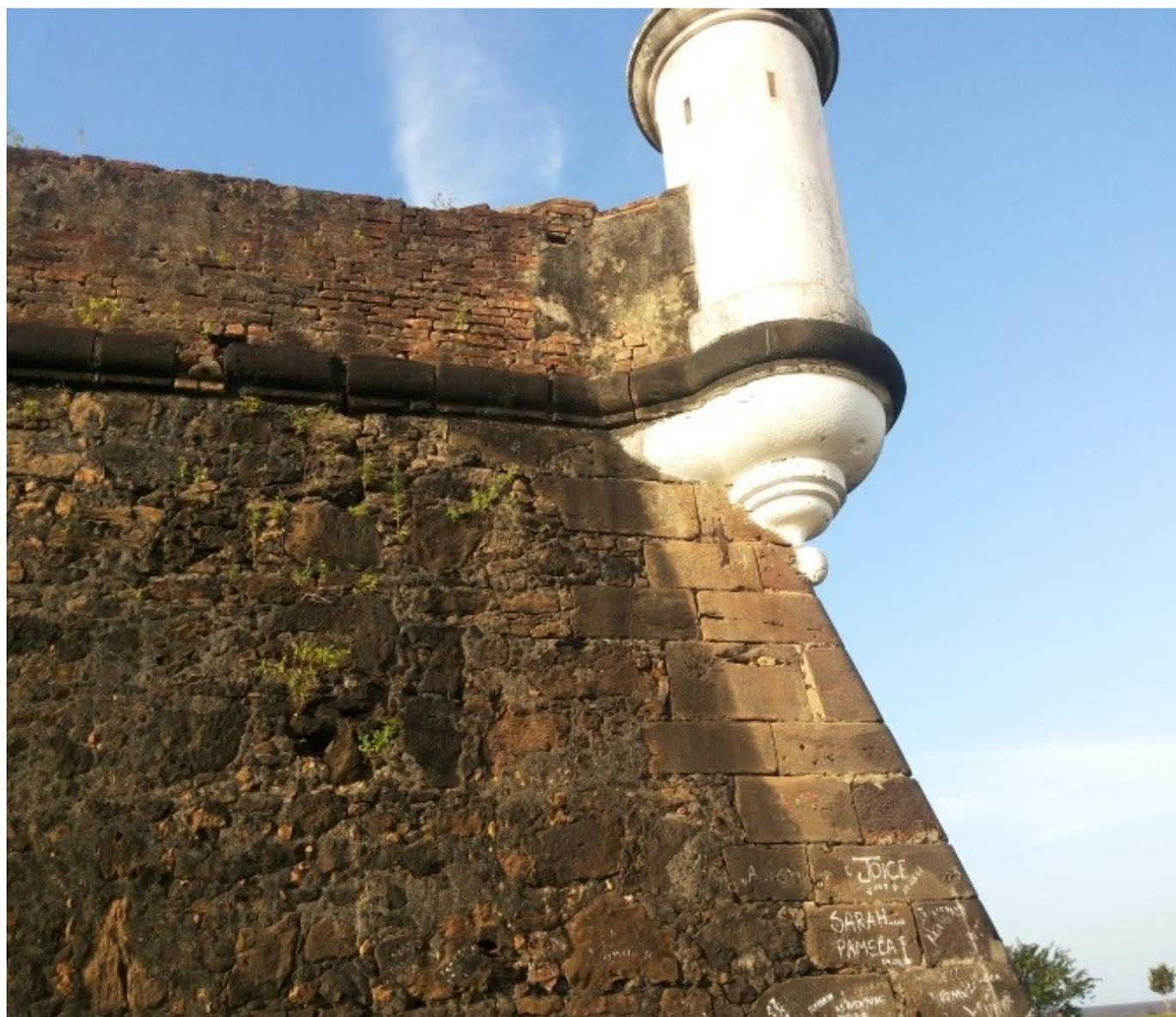
Figura 1. Aspecto da muralha da FSJM onde se observam diversos tratamentos de arenitos ferruginizados: em blocos em cantaria formando os cunhais, em cortes curvos compondo o cordão de contorno das muralhas e nas bases das guaritas, neste caso encobertas por pintura.
