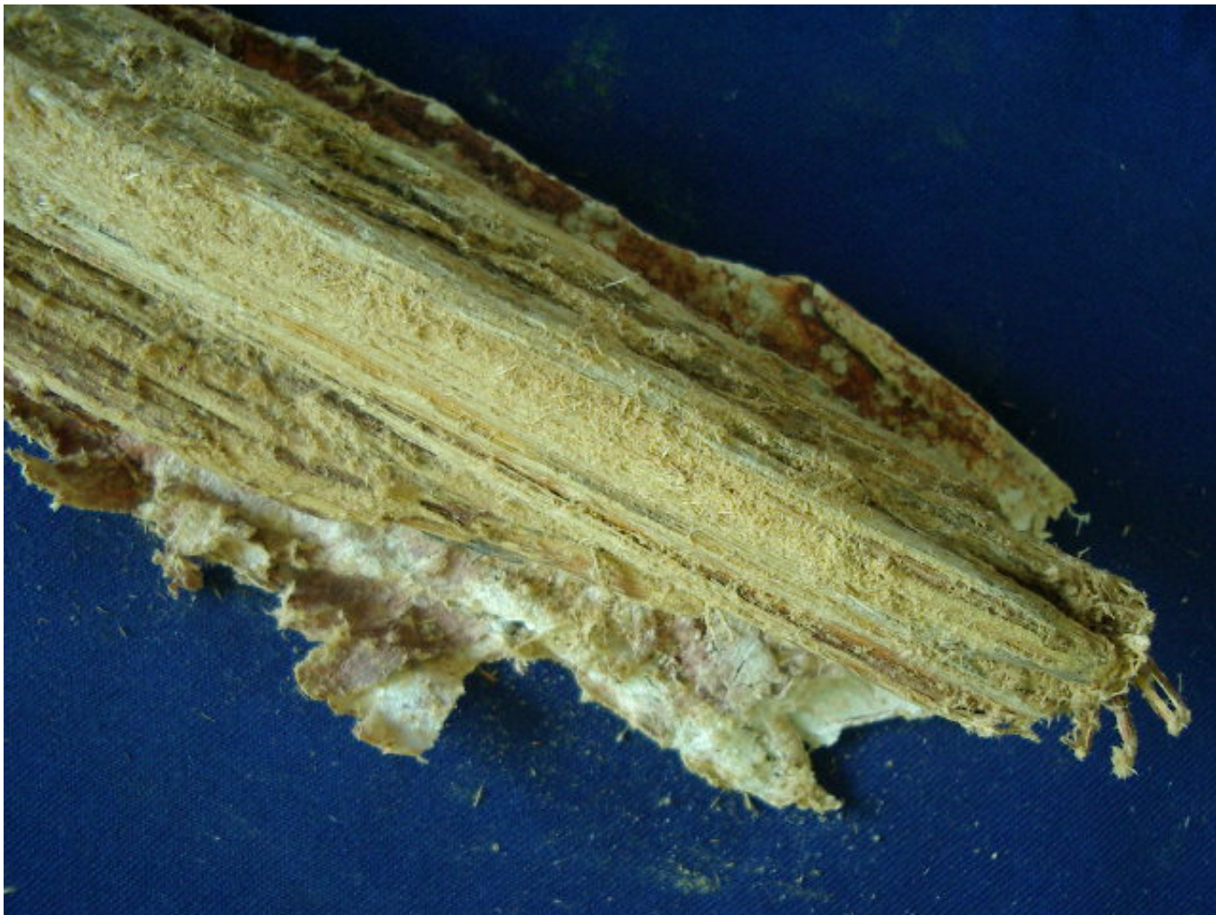
750 - Amianto - Procedência desconhecida
