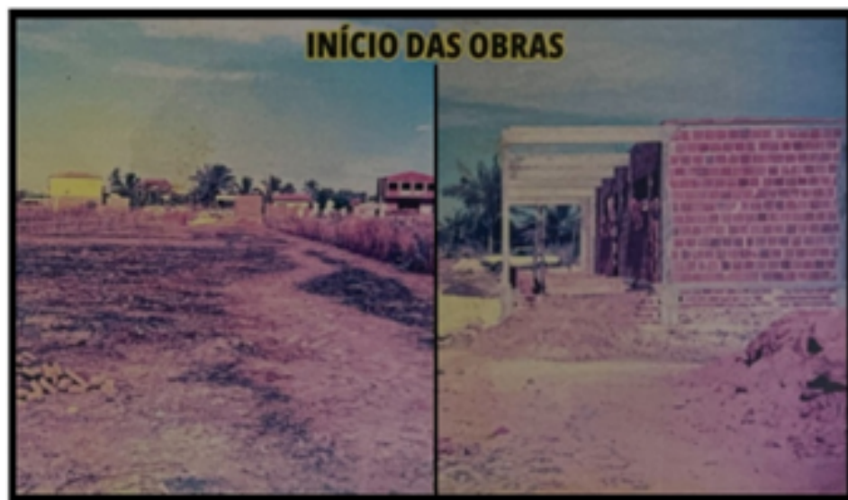
Figura 1 - Terreno localizado na Rua Coronel Pompeu, 1481, medindo 6,00m x 156m. Detalhe do início das obras.
