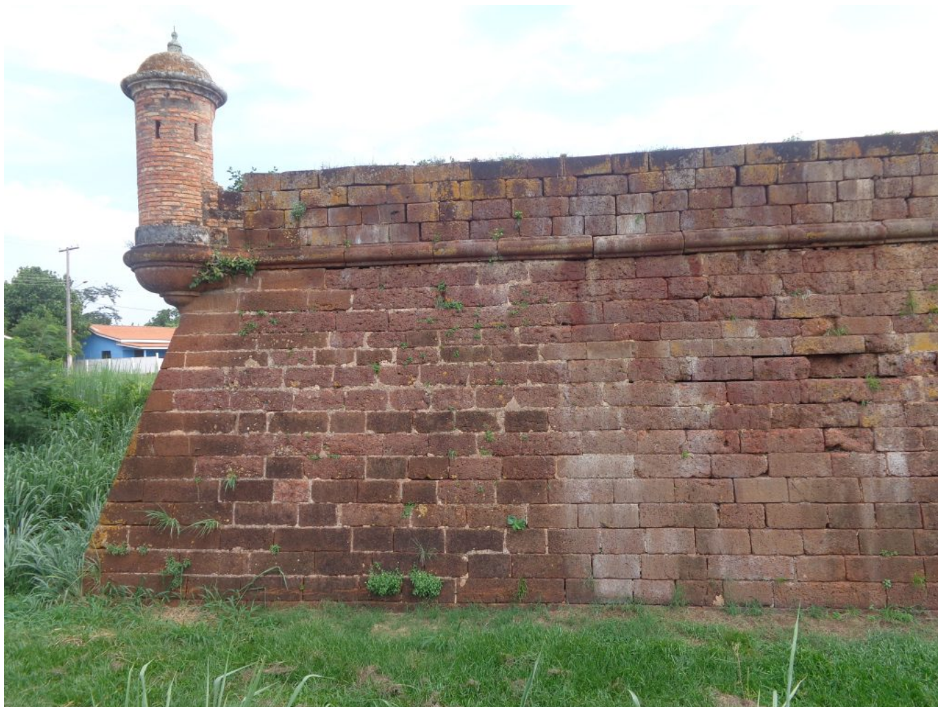
Figura 5 - Muralha da face norte do Baluarte de Santo Antônio de Pádua onde se observam as linhas claras de blocos contrafiados de crostas lateríticas em 17 fiadas (as da base parcialmente encobertas pela vegetação e solo), interceptada pela linha do cordão seguida de mureta com 4 fiadas, com dimensões variadas e altura regular com cerca de 32cm.
