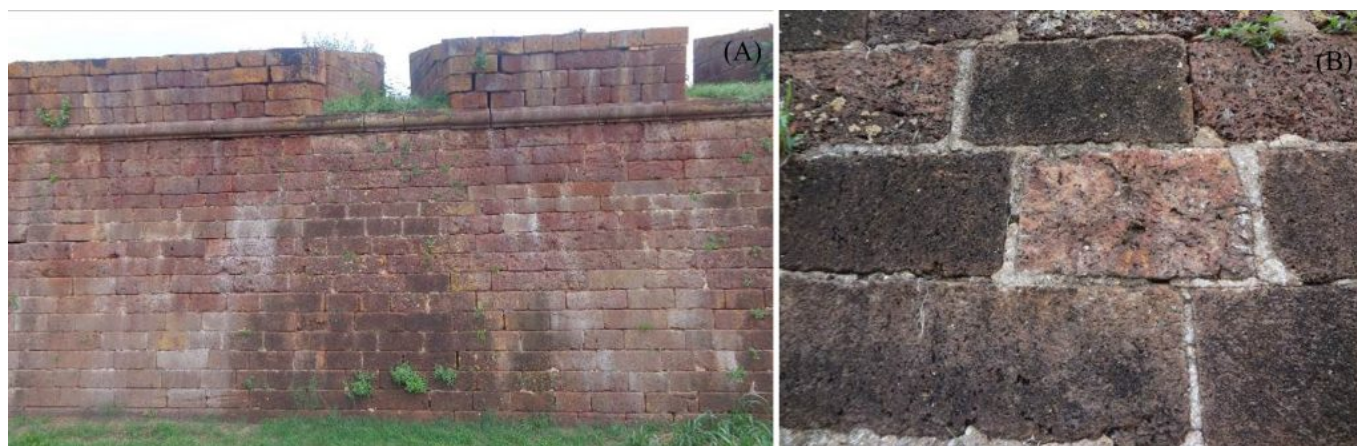
Figura 6 - (A) Face do baluarte de Santo Antônio de Pádua onde são facilmente identificáveis os blocos de crostas lateríticas provenientes tanto do topo do perfil correspondendo a blocos de crostas maciças e mais resistentes, quanto de áreas mais próximas do mosqueado, estas mais suscetíveis ao intemperismo. (B) Detalhe de blocos de crostas maciços em contraste com outros mais cavernosos e próximos do mosqueado.
