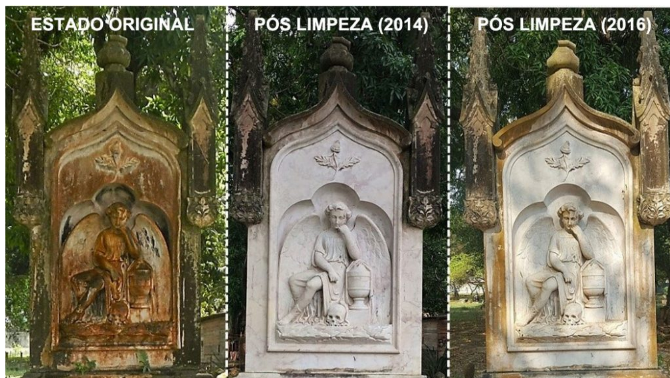
Figura 1: Evolução dos resultados de limpeza química com emplastro de bentonita e biocida.
