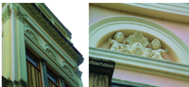
Figura 1. a) Vistas dos ornamentos em estuque da fachada do Palacete Augusto Montenegro, construído em 1903.
